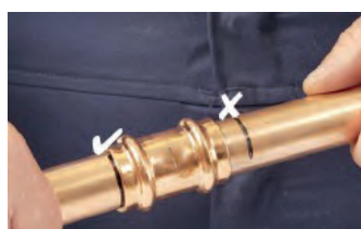
5. Insérer le tube dans le raccord
