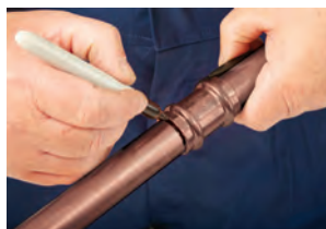
4. Assemblage et marquage de la profondeur d'insertion
