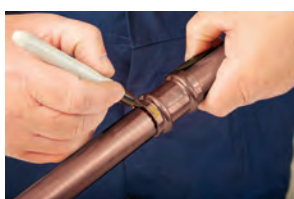
4. Assemblage et marquage de la profondeur d'insertion
