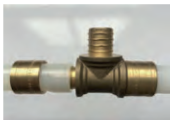
3. Insérer le raccord dans le tube
