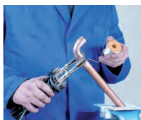
5- Appliquer la soudure
