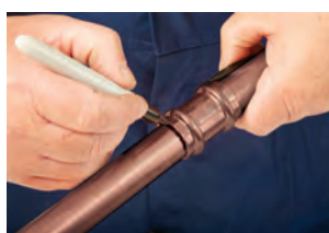
4. Assemblage et marquage de la profondeur d'insertion
