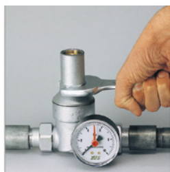
2. Отвинтите колпачок, используя ключ на 32 мм.
