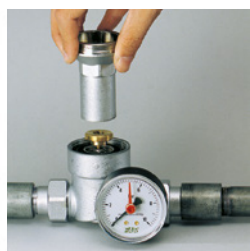
4. Переверните колпачок и навинтите его на регулировочное кольцо.
