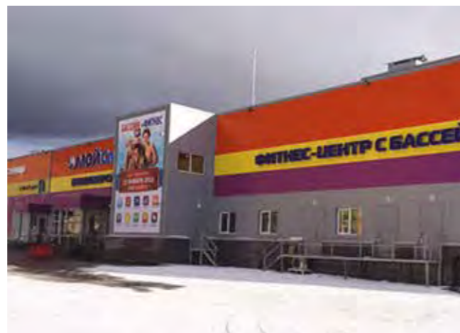
Фитнес-центр «Мой спорт Белоозерский», пгт Белоозерский, МО POWER HT, общая мощность — 1,5 МВт
