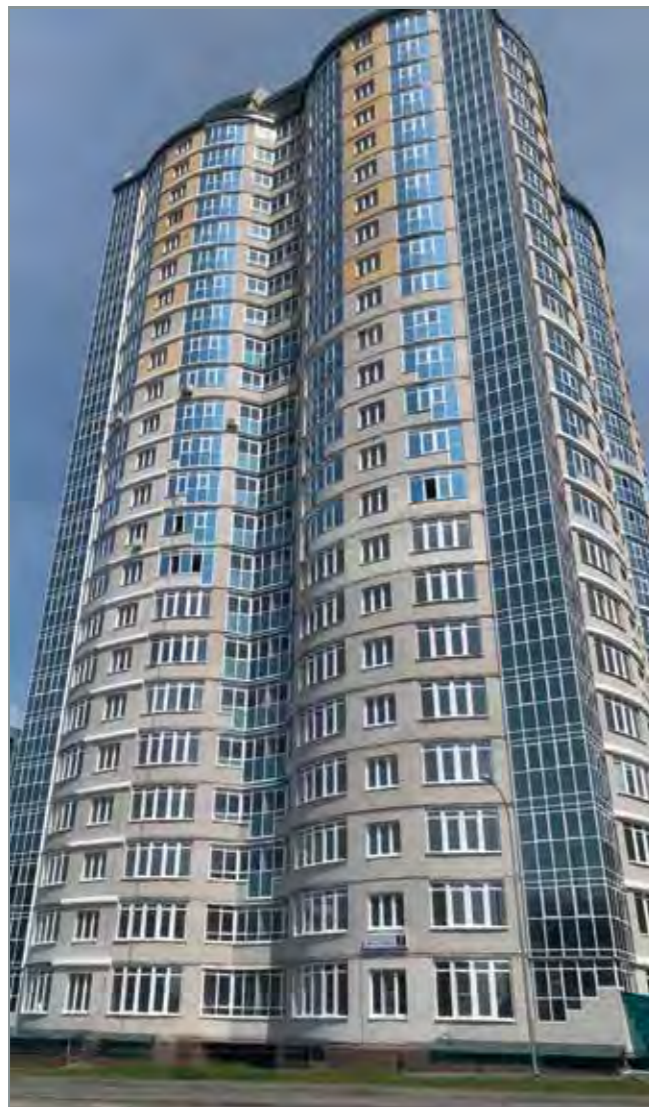
Жилой дом, г. Чебоксары POWER HT-A и POWER HT, общая мощность — 2,6 МВт
