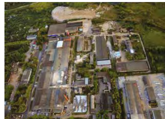
Картонно-рубероидный завод, г. Рязань Duo-tec MP, общая мощность — 1,8 МВт
