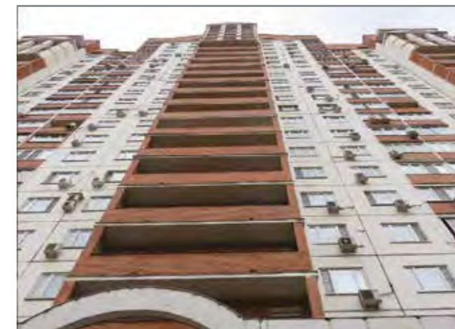
Жилой дом, г. Москва POWER HT, общая мощность — 2,2 МВт
